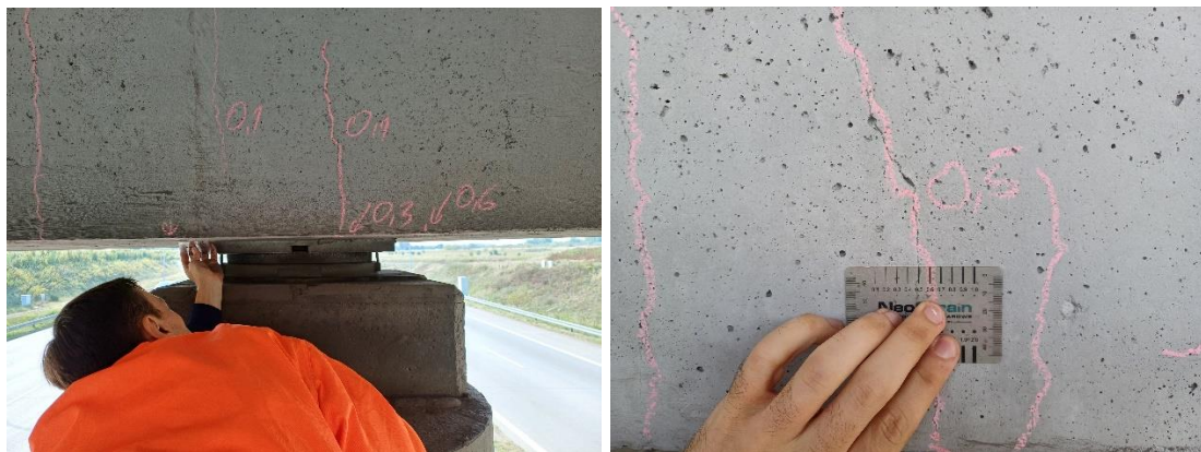
Rys. 3.2. Przebieg prac polegających na inwentaryzacji uszkodzeń dźwigarów głównych przęseł wiaduktu
