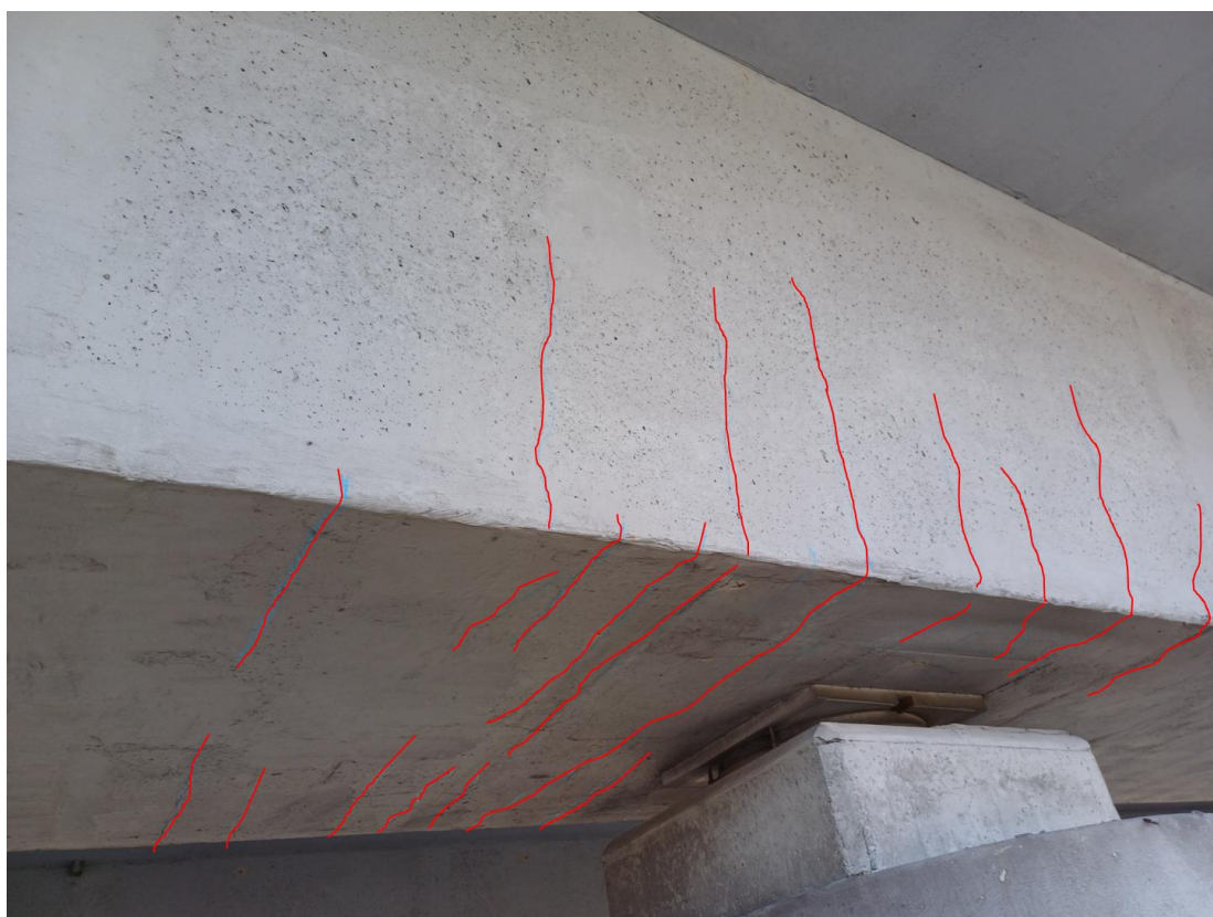
Rys. 3.13. Dźwigar nr 3 (północny) – zarysowania betonu w pobliżu filara, strona północno-wschodnia
