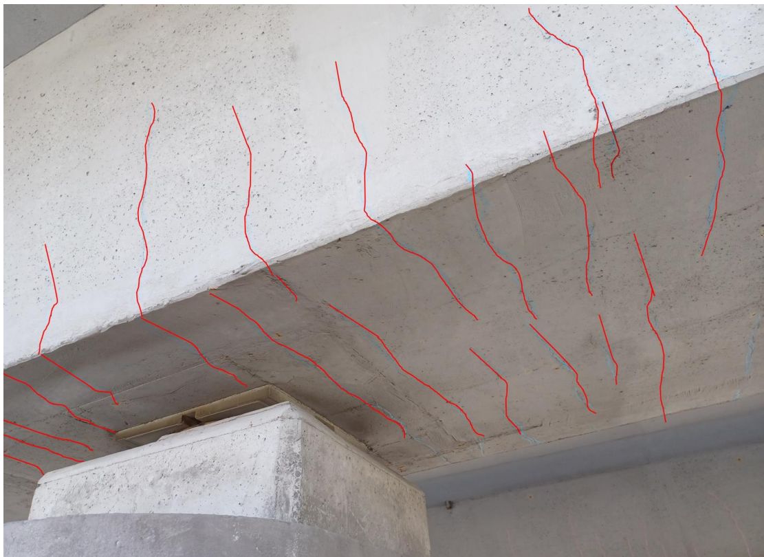
Rys. 3.12. Dźwigar nr 3 (północny) – zarysowania betonu w pobliżu filara, strona północno-zachodnia
