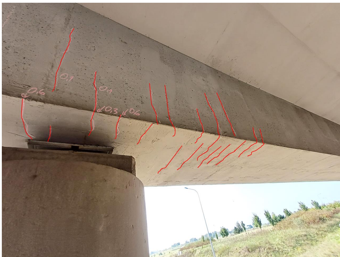
Rys. 3.9. Dźwigar nr 1 (południowy) – zarysowania betonu w pobliżu filara, strona północno-zachodnia
