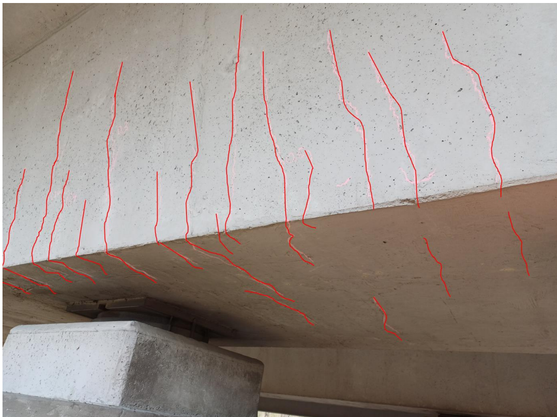
Rys. 3.8. Dźwigar nr 1 (południowy) – zarysowania betonu w pobliżu filara, strona południowo-wschodnia
