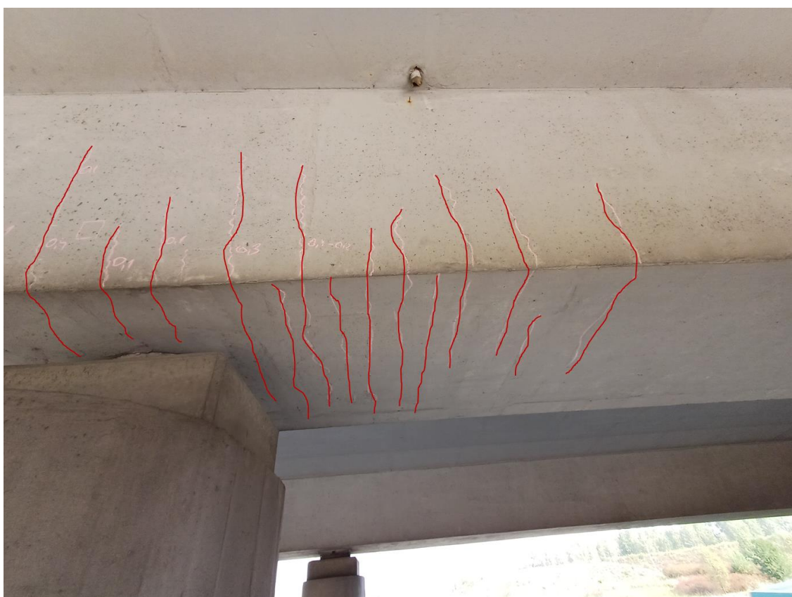
Rys. 3.11. Dźwigar nr 2 (wewnętrzny) – zarysowania betonu w pobliżu filara, strona południowo -wschodnia
