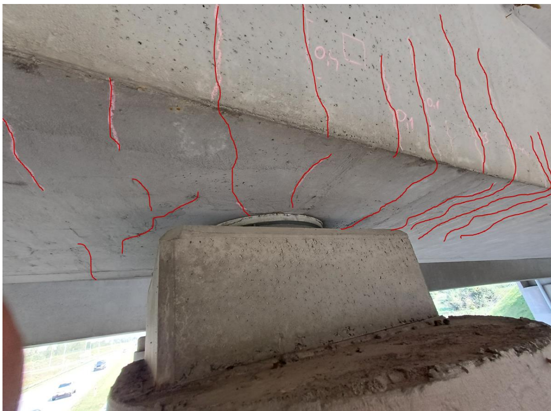
Rys. 3.10. Dźwigar nr 2 (wewnętrzny) – zarysowania betonu nad filarem, widok od strony południowej
