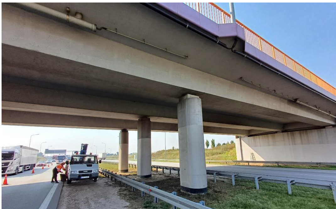
Rys. 3.1. Oględziny konstrukcji przeseł i podpór z wykorzystaniem podnośnika kosowego
